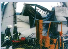
Totalschaden beim Umfüllen von brennbaren Flüssigkeiten
